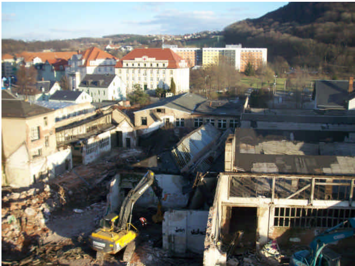
Abbruch ehemaliges Plastmaschinenwerk in Freital für Stadt Freital
